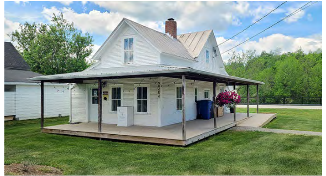
La maison en 2021. Plan en forme de L, ajout de deux appentis (avant à gauche pour l'entrée et à l'arrière), et galerie.
