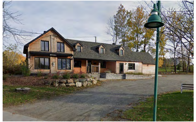
La maison en 2021 (Google Maps). Extensions latérales ajoutées.
