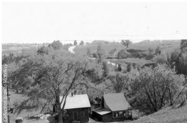
La maison et sa voisine disparue, vue de la colline (1930-1940).
