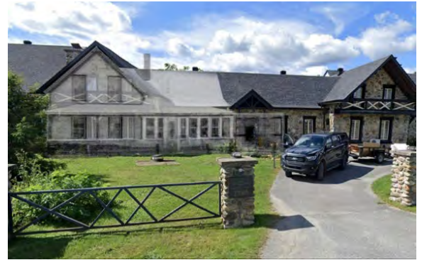
Montage photo : le « fantôme » de la maison, dont la structure est maintenant enchâssée dans le bâtiment du Lion d'Or.
