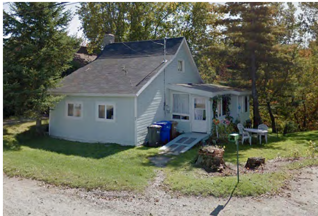
Aujourd'hui. Adjonction avant et véranda latérale en appentis.
